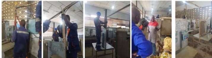
Installation du câble d'alimentation par les élèves
